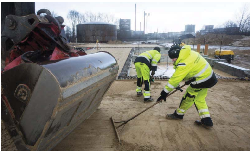
Lokale håndværkere i gang med flisværkets fundament. Bagved står soklen til akkumulerings-tanken, mens gærfabrikken skimtes i baggrunden.
